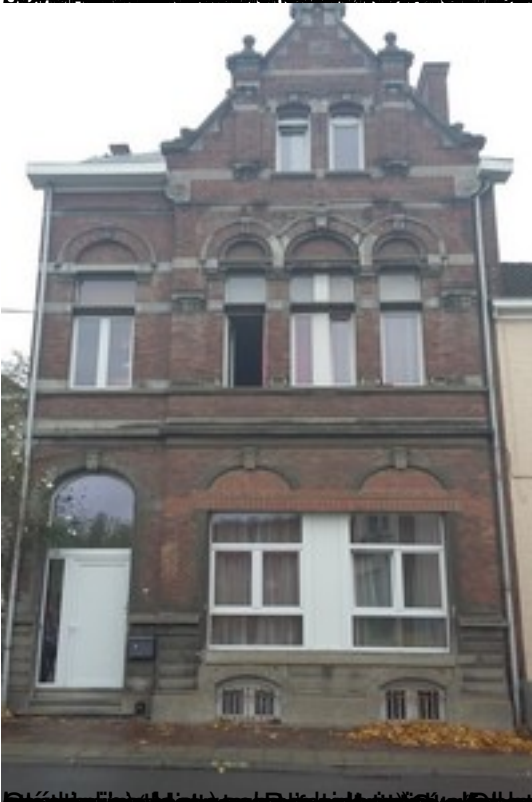
Classe 1105 - rénovation de confort au sein d'une grande habitation protégée à Court Saint Etienne (10) - Belgique (région de Bruxelles-Capitale) - type de patrimoine
